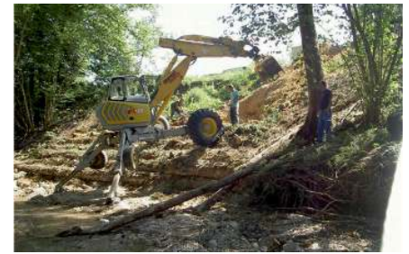
Die Instandsetzung des Böschungsanrisses war mitunter eine Herausforderung für Mensch und Technik. So musste beispielsweise mit einem Spezialbagger direkt im Fluss gearbeitet werden.
