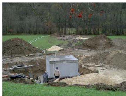
Oben: Die 9 m langen Spundwände werden eingebracht. Links: Anlieferung der Fertigbetonteile des Sammel-schachts. Rechts: Blick auf den fertiggestellten Rohrkeller für die Pumpentechnik.
