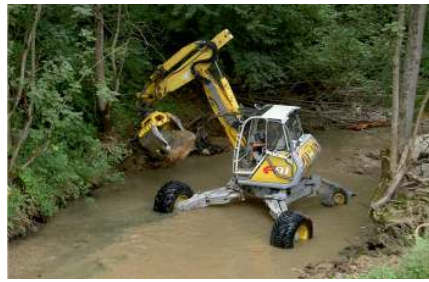
Die Instandsetzung des Böschungsanrisses war mitunter eine Herausforderung für Mensch und Technik. So musste beispielsweise mit einem Spezialbagger direkt im Fluss gearbeitet werden.
