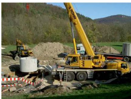
Oben: Die 9 m langen Spundwände werden eingebracht. Links: Anlieferung der Fertigbetonteile des Sammel-schachts. Rechts: Blick auf den fertiggestellten Rohrkeller für die Pumpentechnik.
