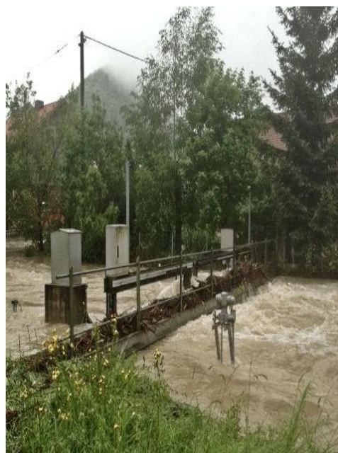
Die Wehranlage an der Fils mit den ganz geöffneten Stauklappen beim 20 jährigen Hochwasser am 1.06.2013
