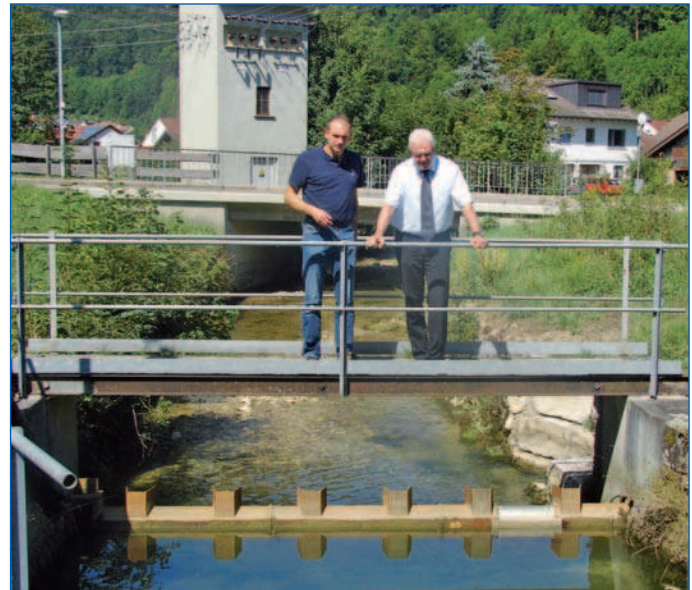
Trotz geringerer Wassermenge kann an der Eyb fast die doppelte Menge an Strom als in Bad Überkingen erzeugt werden.
