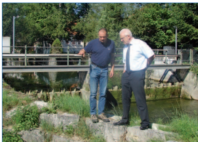
Wassermeister Pulvermüller erläutert Bürgermeister Polaschek die Funktion der modernen Wehranlage in Hausen an der Fils.
